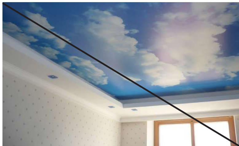
Плохо Натяжные потолки. Потолки с рисунками
