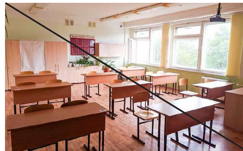
Плохо Линолеум под дерево
